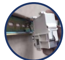
Ejemplo de fijación en carril DIN
